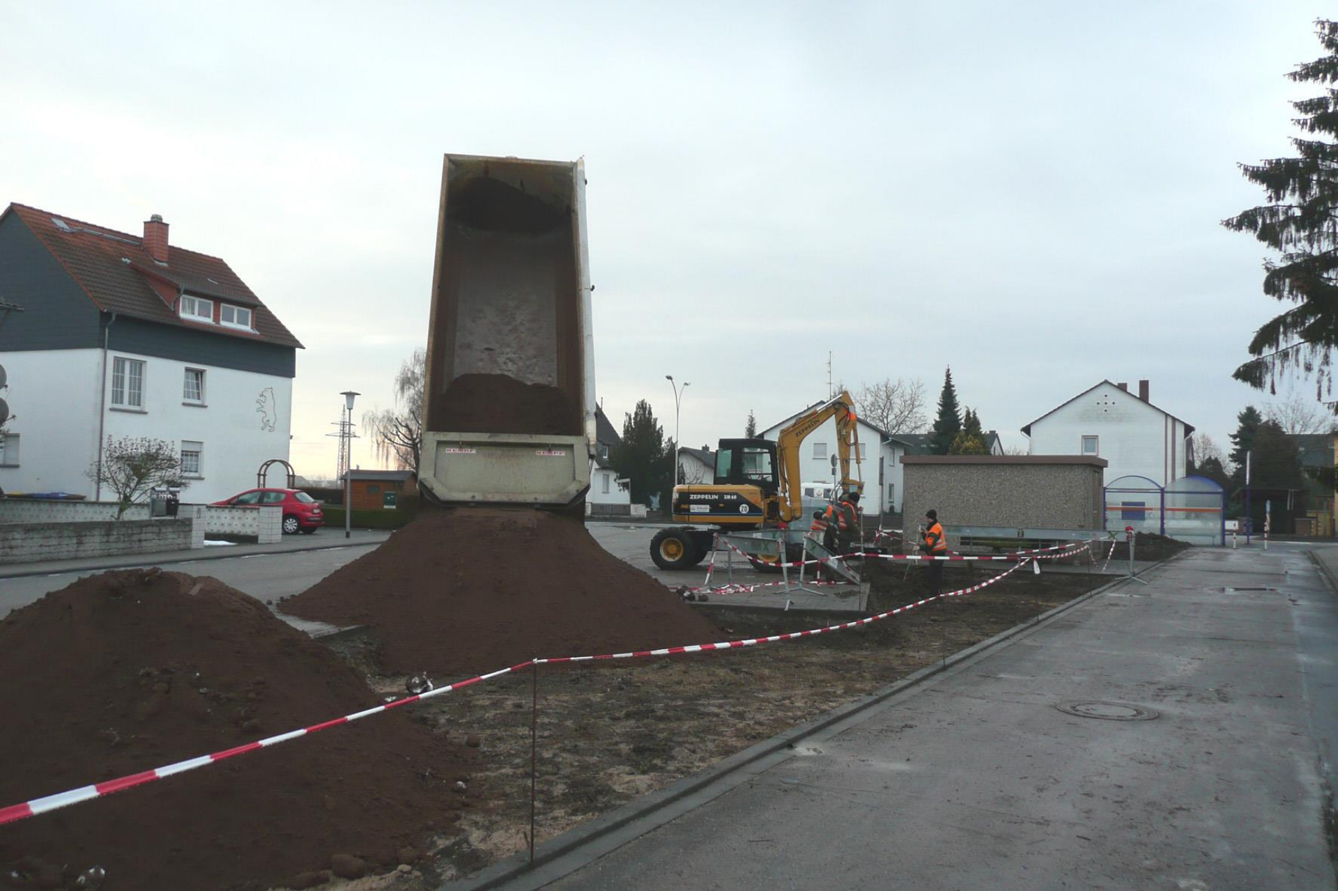
Einbau des neuen Vegetationssubstrats (08.02.2010)
