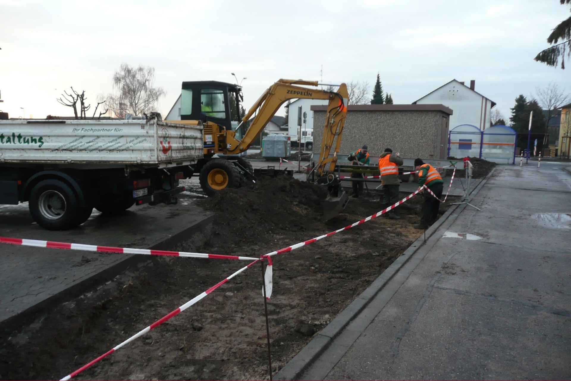
UMGESTALTUNG: Entnahme des alten Oberbodens (04.02.1010)
